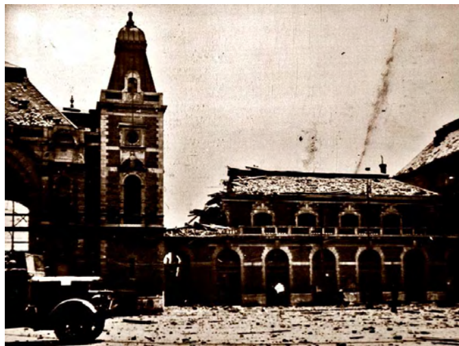
A Nagyállomás épülete 1944. június 2.
